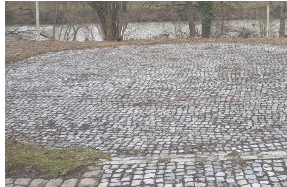
Klein und Großpflaster Granit wird für den Wegebau der Plätze wiederverwendet
